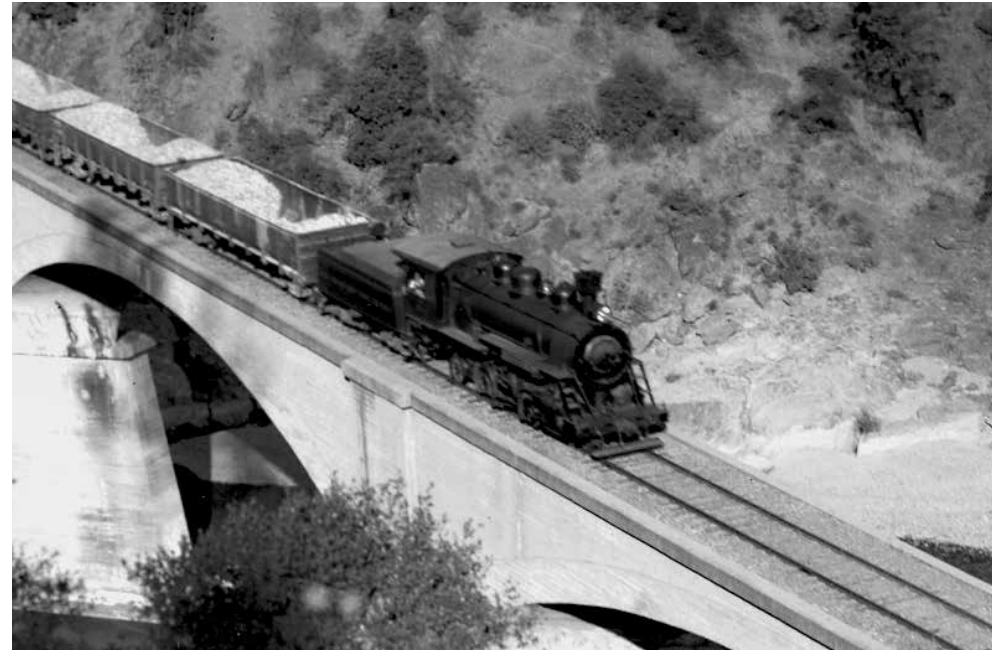
Puente Ferroviario de las Canteras de la Montaña (Mountain Quarries Railroad Bridge), alrededor de los años treinta
