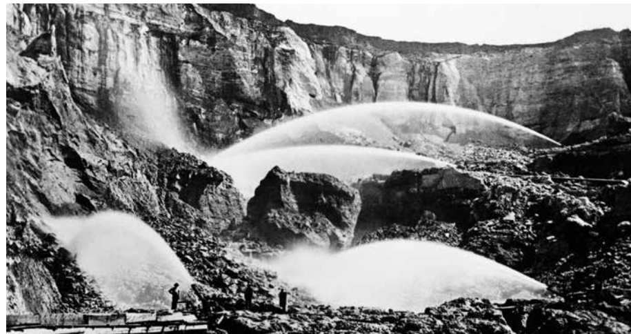
Monitores de alta presión lavan el oro de riveras antiguas.
